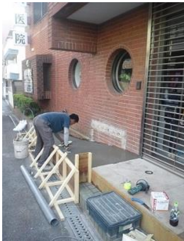
スロープ工事
